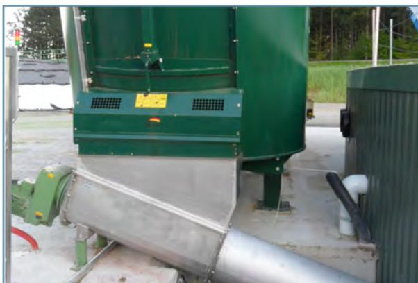
Schneckenförderstrang als Direkteintrag zum Befüllen eines Fermenters
