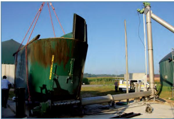
Schritt 1: Der alte Dosierer wird abgebaut
